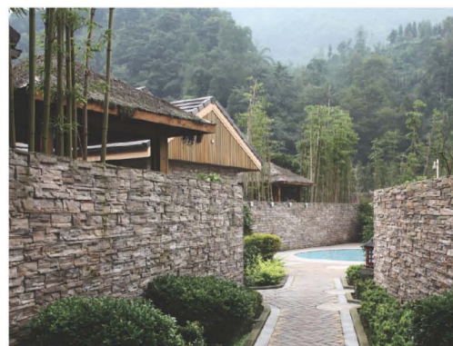
① 成都花水湾金陵酒店 Jinling Huashuiwan Hotel Chengdu
